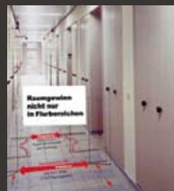
Falttüranlage als Schachtverkleidung im Laborflur, mit oberer Deckenblende
